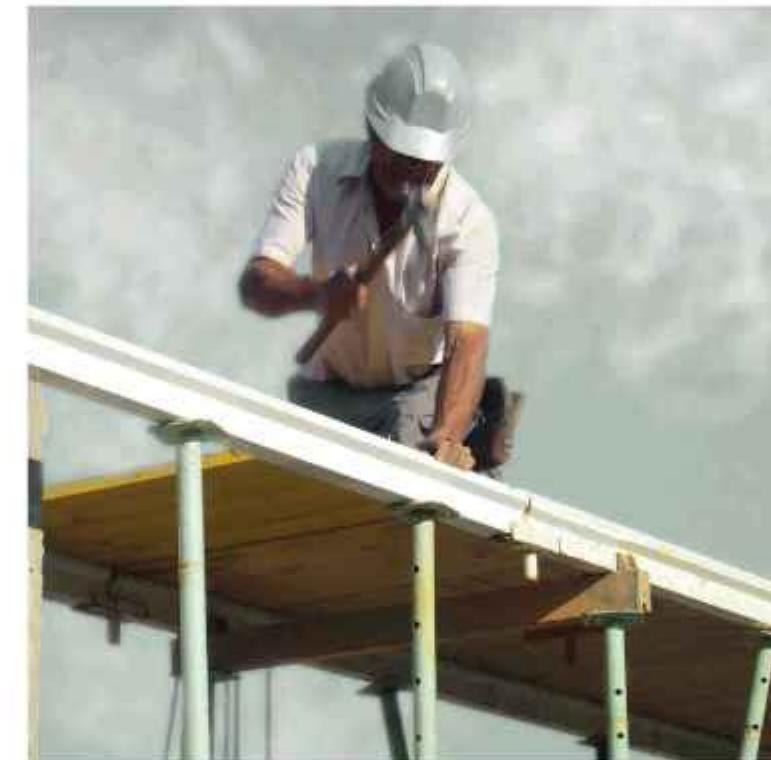
En un encuentro ortogonal entre encofrados lineales, y gracias a los **cuatro centímetros de apoyo continuo** que ofrece la Extrema a los tableros de madera, éstos pueden descansar 2 tercios de su perímetro sobre un apoyo firme, garantizando un gran nivel de seguridad durante la ejecución de la planta.
