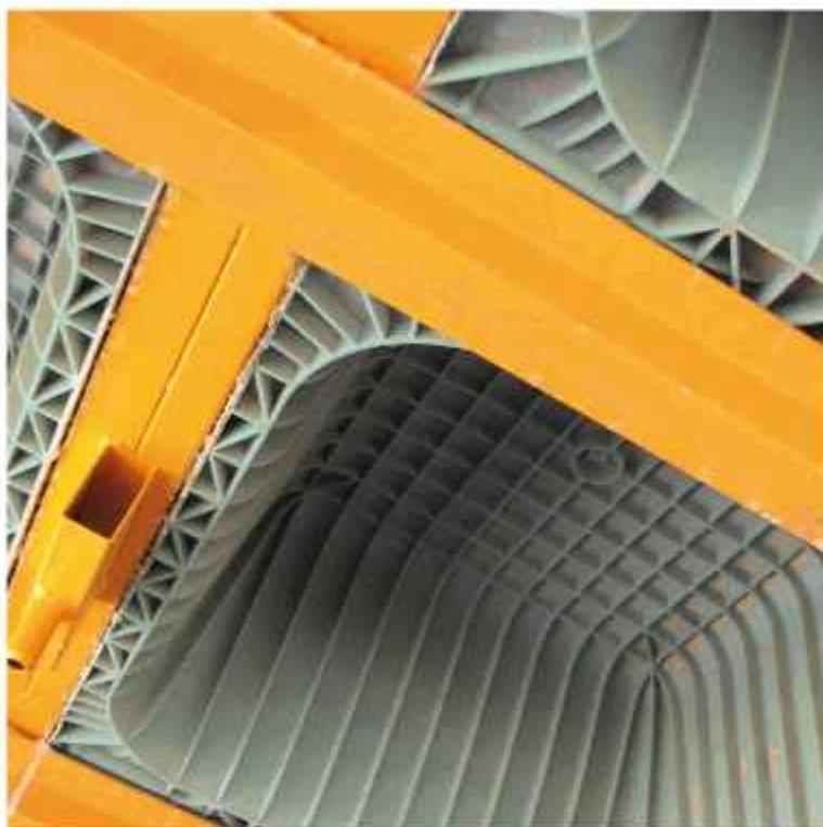
Para la ejecución de la mayoría de forjados aligerados con casetón recuperable, utilizaremos las mismas sopandas EXTREMAS que en la configuración VERSATEC UNO'97 para entablado continuo. Esto permite a nuestro cliente alquilar únicamente apeos de 0,80 cm y arriostradores, si poseen VERSATEC UNO'97 en propiedad.
