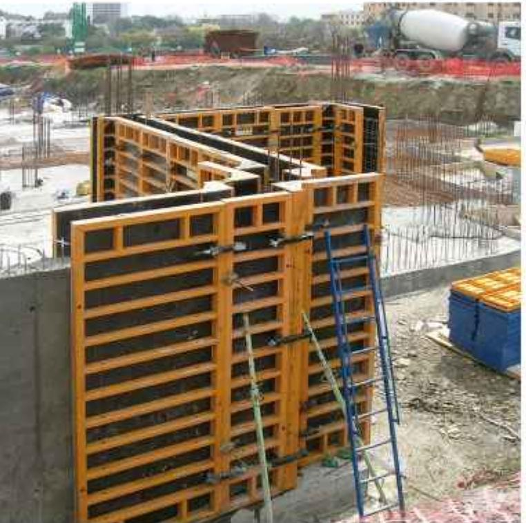
Las distintas **modulaciones**, así como la extraordinaria sencillez en la resolución de cualquier tipo de esquina, permiten a los **encofradores** ejecutar partidas tan singulares como los huecos de ascensor, empleando el mínimo tiempo.
