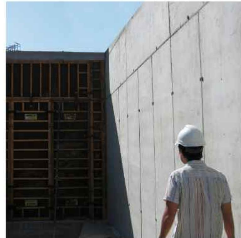
Los paneles quedarán **perfectamente alineados** con la presión que ejerce sobre sus bastidores la Mordaza. Esta capacidad de autoalineado garantiza un perfecto acabado en aquellos muros que requieran una terminación vista, con un importante ahorro en otros elementos y en mano de obra.
