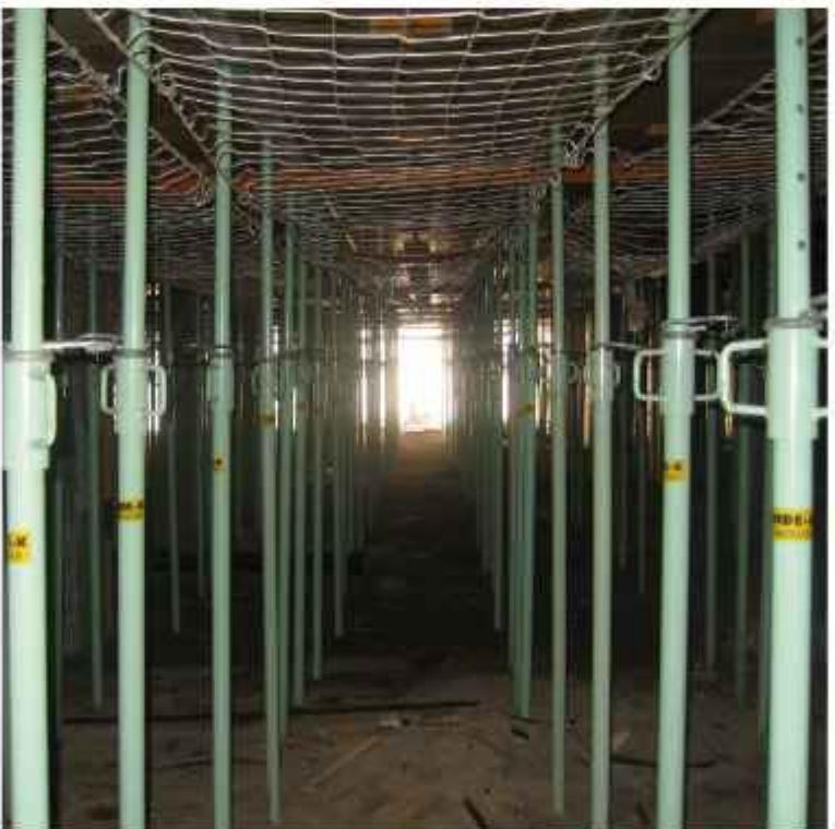
El puntal telescopico INDE-K, constituye uno de los productos de mayor difusión entre las modernas técnicas constructivas y resultan **esenciales** para la ejecución de encofrados horizontales, esta circunstancia nos obliga a utilizar un puntal que reúna las siguientes características:
